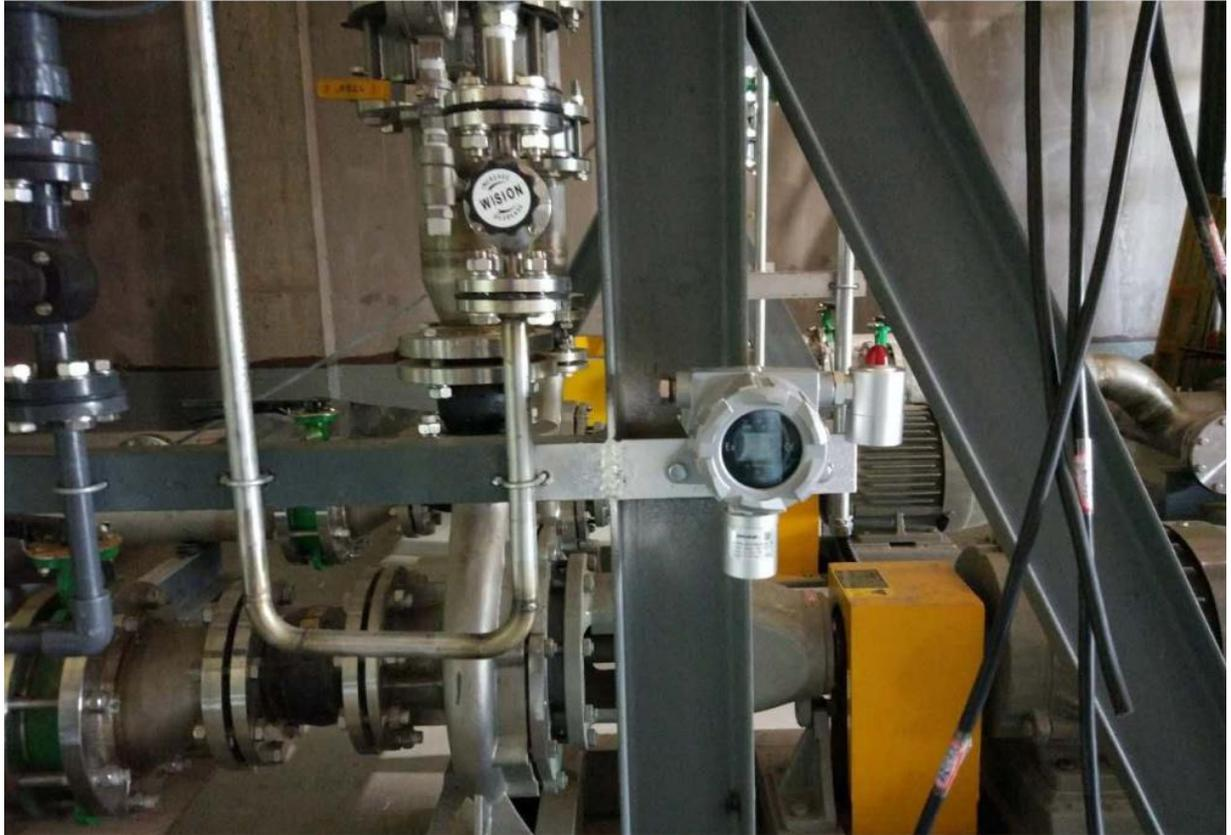
当然很多用户的磷化氢检测仪是和相关系统搭配的。如采集 4-20mA 进 PLC 系统。还有的是磷化氢检测仪和深国安报警控制器结合使用。该报警控制器既可以给磷化氢检测仪供电又可以实时显示气体浓度，同时超标时，还会自动进报警。布线接线也非常简单、也方便用户进行统一管理。重要的是，深国安报警控制器，通过内部的继电器信号还可以联动风机、阀门等设备。气体在超标报警时，同时可以启动或者关闭风机、阀门。这样一来可以大大提高安全指数。
